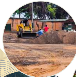
Remodelación canchas de tenis
